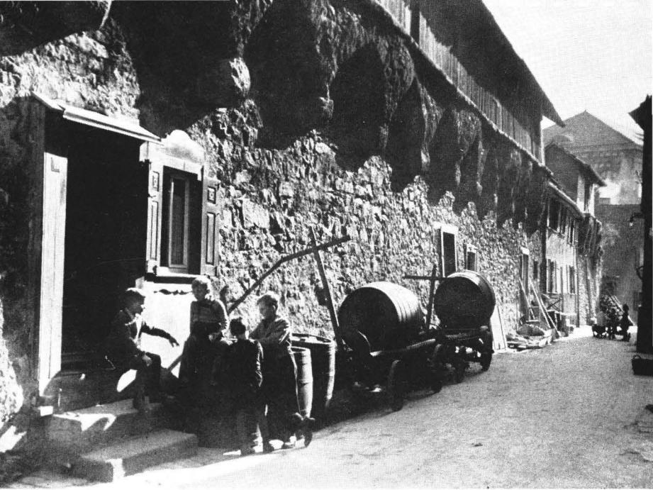
Reutlingen. Mauer Friedrichs II. in der Mauerstraße.
